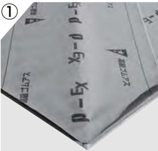
降り棟があるときは、下葦材(アスファルトルーフィング940以上またはゴムアスシート)を水上から水下まで通して敷込み、二重に増貼りして棟下地を取付けます。
